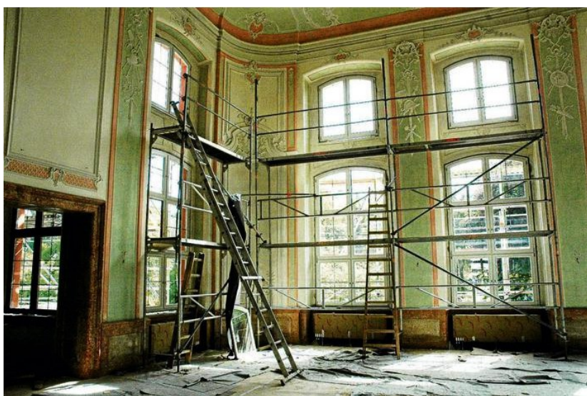
Eingerüstet ist der prächtige Holzsaal. Risse in Wänden und Deckengemälde wurden untersucht, stellten sich zum Glück aber als ungefährlich für die Statik heraus.
